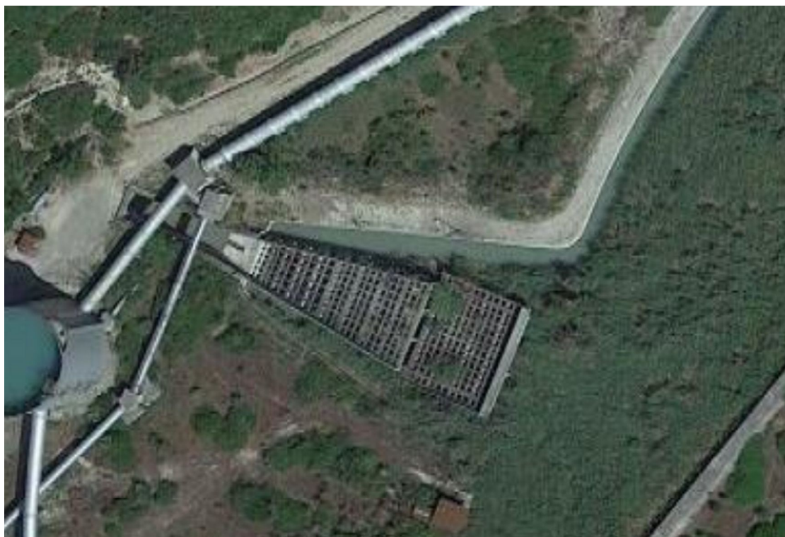
Figura 10: Vasca di dissipazione n. 2 in sinistra.
