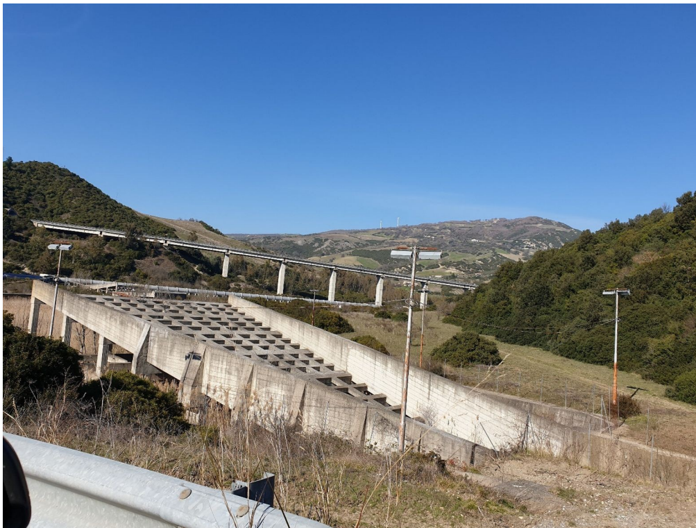
Figura 9: Vasca di dissipazione n. 1 in destra.
