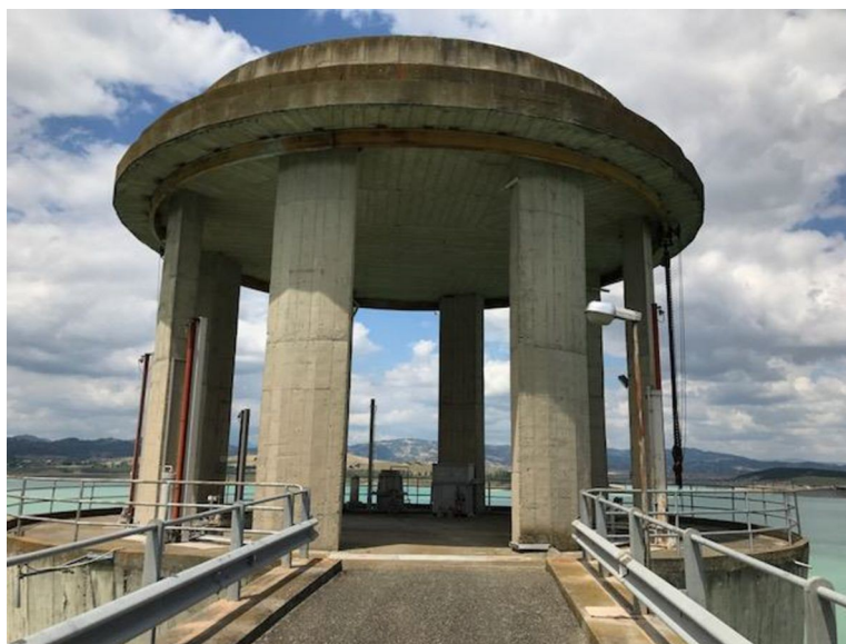
Figura 12: Torre di presa.
